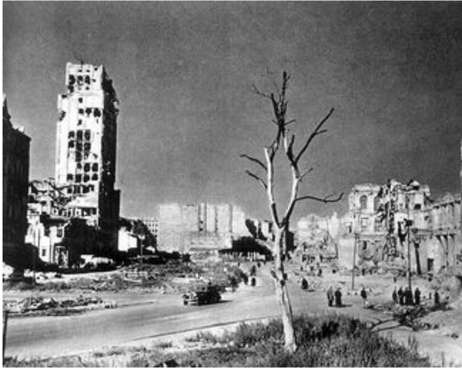
Plac Warecki (obecnie Powstańców Warszawy), w głębi ruiny gmachu Prudentialu (obecnie Hotel Warszawa), fot. Edward Falkowski, Warszawiacy , Warszawa 1970.
